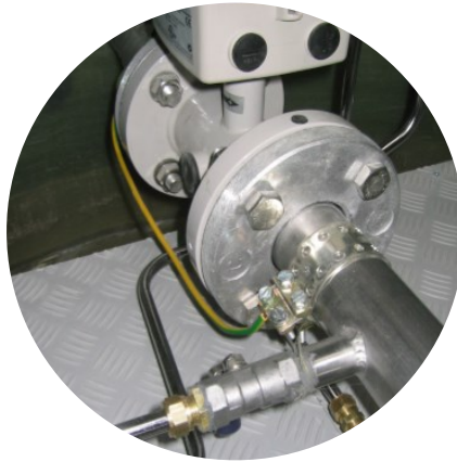
Painetieto välitetään impulssi-putkituksella instrumenteille
