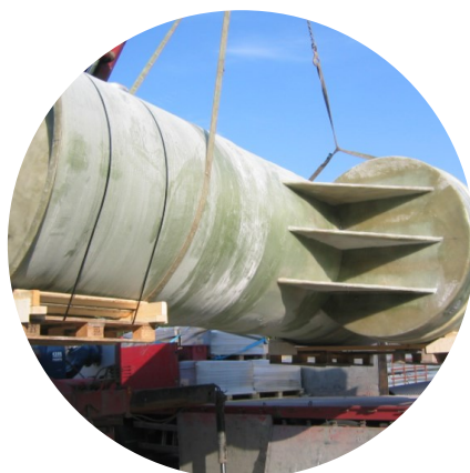
Turvapumppaamot toimitetaan myös valmiiksi asennettuina
